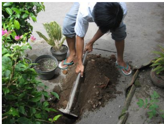
Gambar 15. Foto saat penggalian tanah untuk pemasangan tiang antenna.
