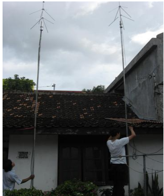
Gambar 14. Foto antenna radio transmiter & reciever
